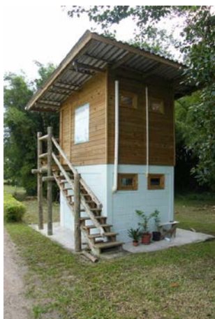
Figura 01: Banheiro seco separador implantado.
