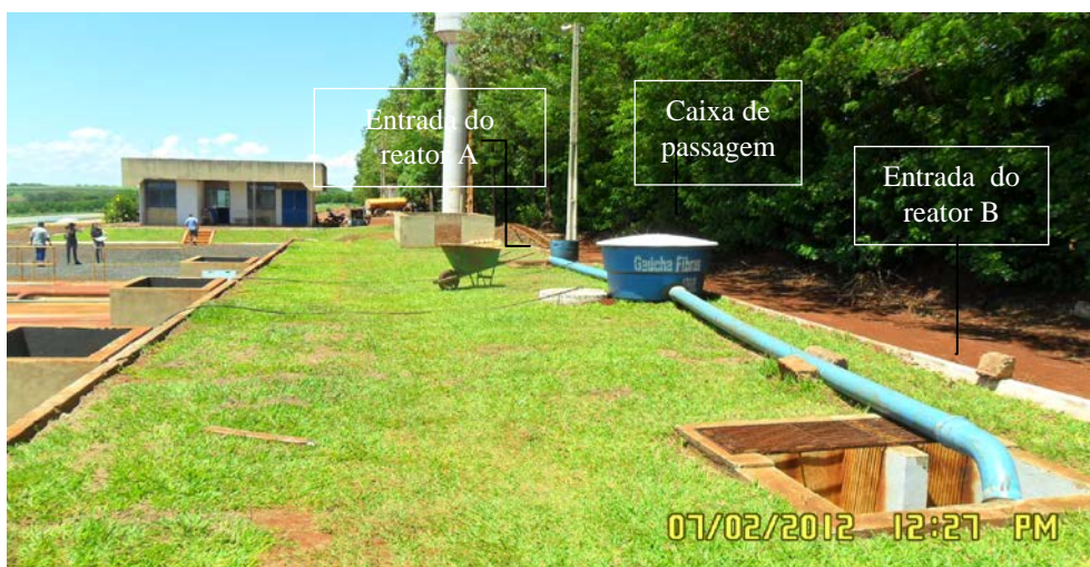
Figura 1.1 – Vista lateral da caixa de passagem e da ligação até a caixa de entrada dos reatores A e B na ETE de Itumbiara.
