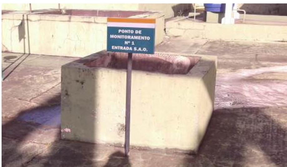
Figura 3: Entrada do separador de água e óleo.
