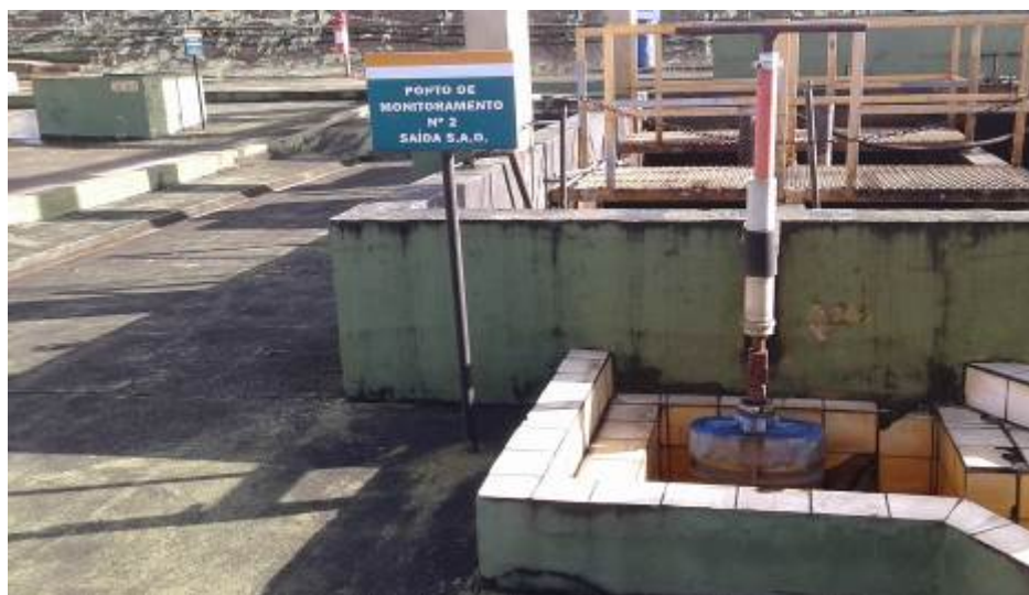
Figura 4: Saída do separador de água e óleo.
