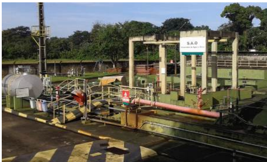
Figura 2: Separador de água e óleo.
