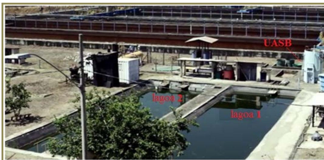
Figura 2 - Sistema experimental em escala real composto por Reator UASB seguido de duas lagoas de polimento do CePTS/UFMG.
