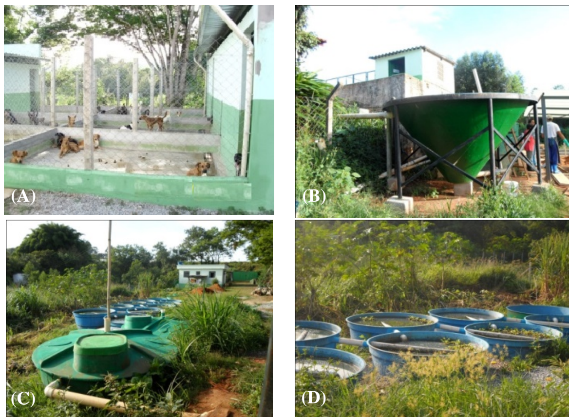
Figura 1: Sistema de tratamento dos efluentes do canil Parque Francisco de Assis na cidade de Lavras-MG: (A) visualização da parte externa das baias; (B) decantador; (C) sistema fossa-filtro anaeróbico; e (D) tanques de estabilização.
