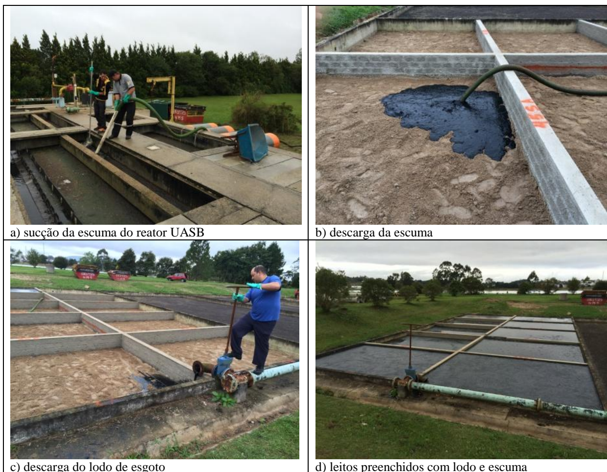
Figura 4: Etapas no preenchimento dos leitos de secagem de espuma e lodo de esgoto, ETE Menino Deus (RMC) (abril, 2014).
