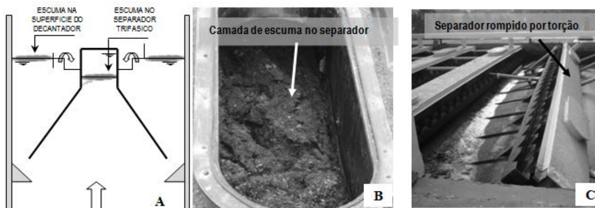
Figura 1 – (a) Regiões de acumulação de espuma em reatores UASB. (b) espuma acumulada no separador trifásico vista de uma escotilha de inspeção; (c) coifa rompida por torção ETE-Piçarrão-SP.
