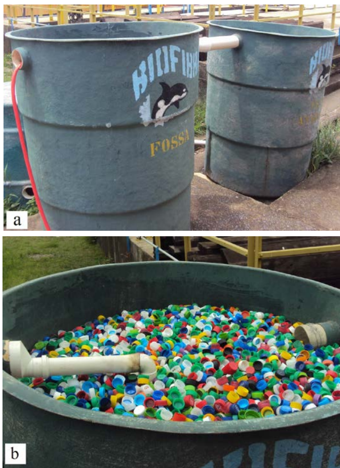
Figura 1: (a) vista geral do sistema tanque séptico e filtro anaeróbico; (b) detalhe do filtro anaeróbico com meio suporte de tampas plásticas reutilizadas.
