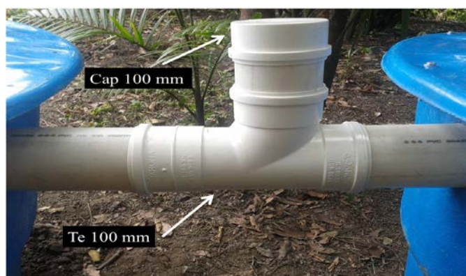
Figura 3: Tê de inspeção e Cap de 100 mm.
