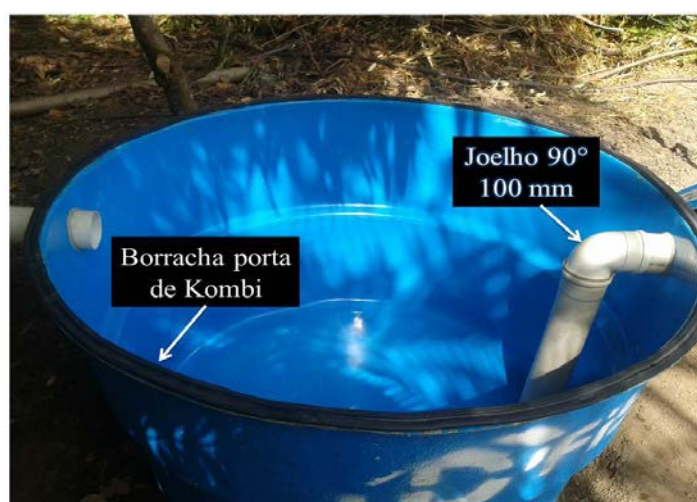
Figura 2: Vedação das caixas da Fossa Séptica Biodigestora com borracha macia.
