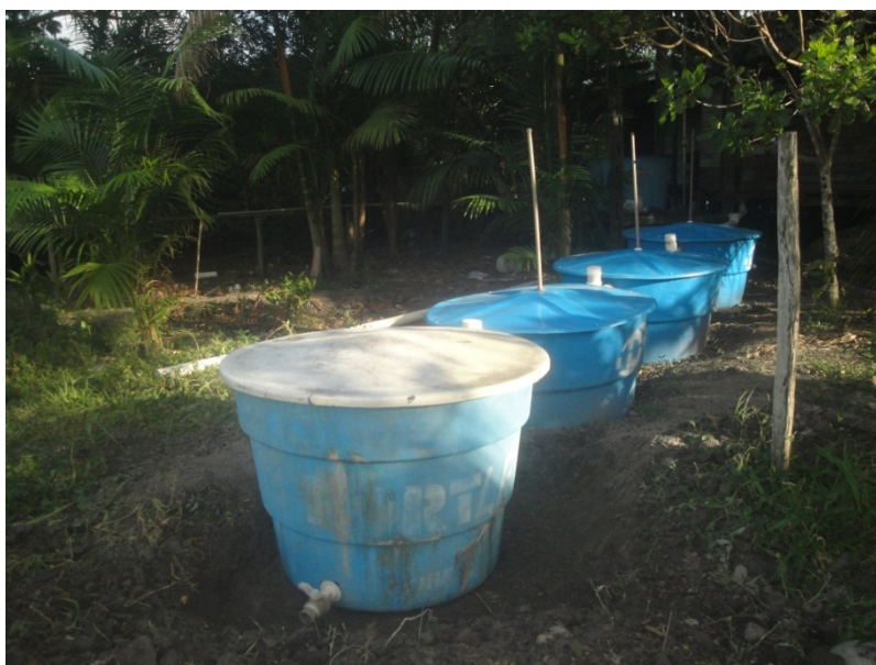
Figura 6: Sistema com três módulos de fermentação e um de armazenagem do efluente tratado.
