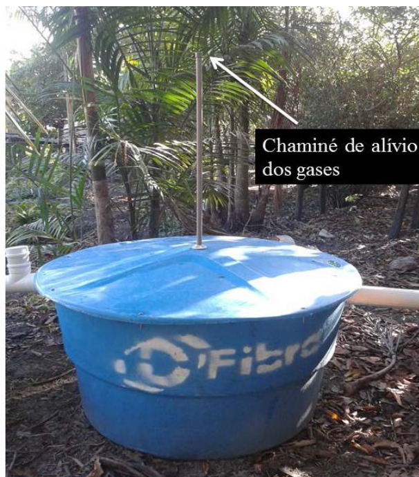
Figura 4: Sistema com chaminé de alívio dos gases.
