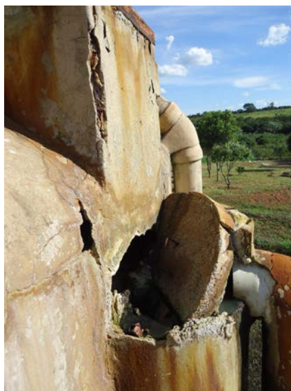
Figura 3 - Detalhe do sifão da saída do reator degradado.
