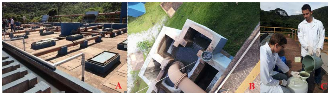
Figura 7 - Reator UASB ETE Itabirito (A- Topo do reator; B- Caixa receptora do efluente após a saída do UASB; Momento da coleta do efluente). Fonte: autores (2015).
