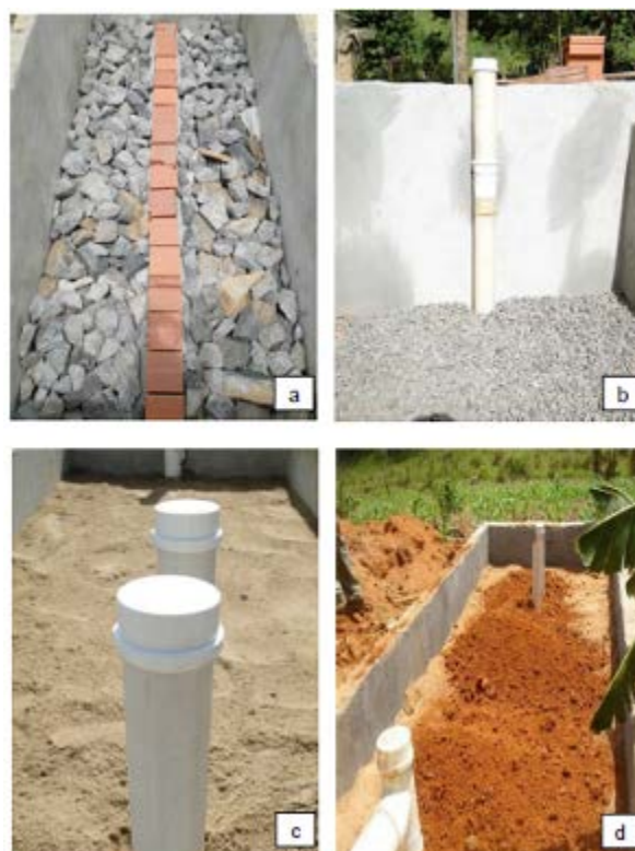
Figura 2 – Passo a passo da construção participativa dos módulos de fossa verde no Posto de Saúde da comunidade Paus Branco, A25M. Fonte: Arquivos HIDROSED 2010 apud GRUPO HIDROSED, 2013.
