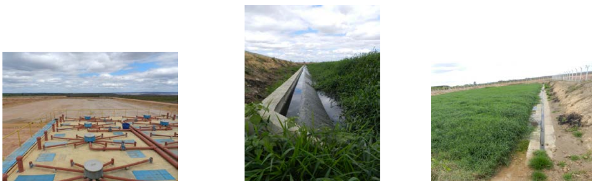
Figura 03: ETE Taiobeiras: RAFAs, Módulos de Capineiras, Sistema de Distribuição e Coleta
