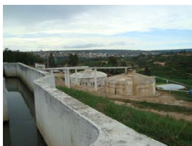
Figura 04: ETE São João do Paraíso: RAFA em ferrocimento, sistema de coleta, efluente clarificado
