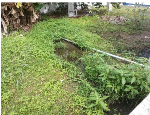
Figura 1: Fossa séptica extravasando na área da Estação de Tratamento
