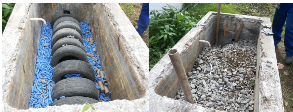
Figura 3: Disposição dos materiais no interior do canteiro
