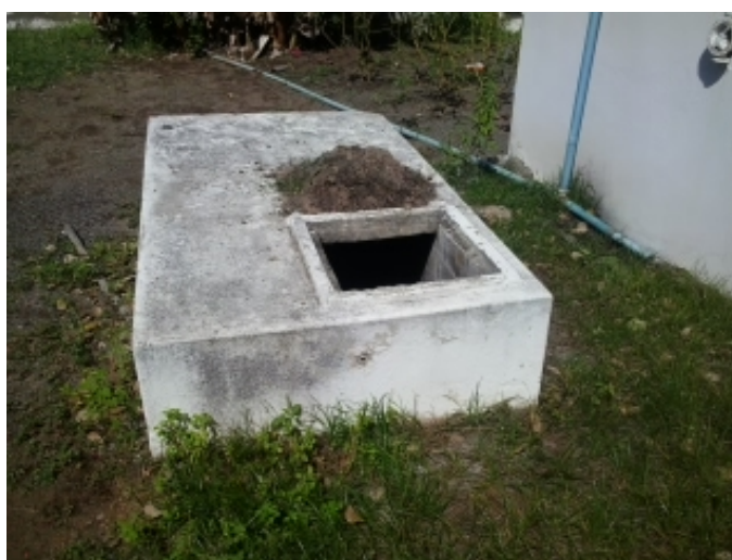
Figura 2: Reservatório existente e utilizado para construção do canteiro bioséptico
