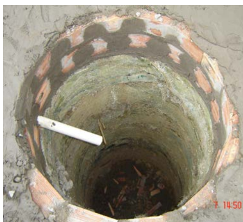
Fig. 2 - Revestimento da fossa com os Anéis dos resíduos.
