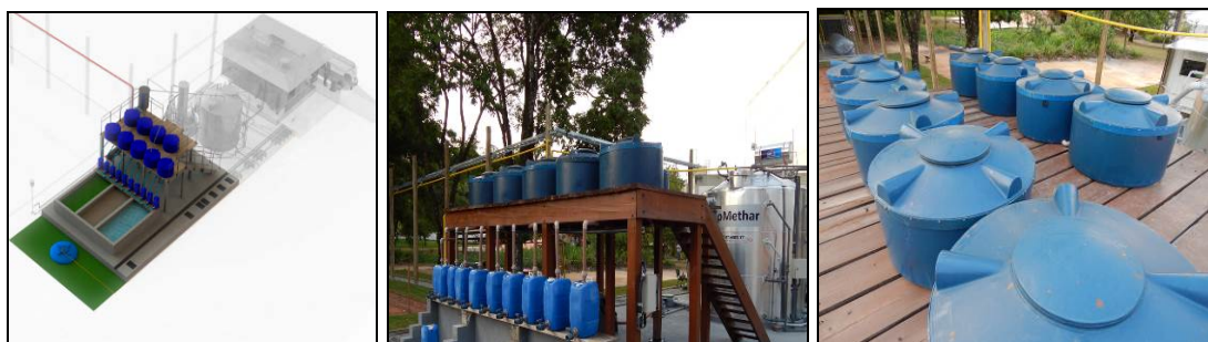
Figura 2: Desenho esquemático da unidade separação sólido-líquido e dos leitos de drenagem
