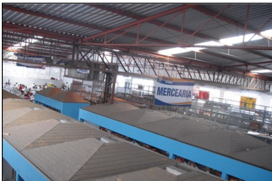
Imagem 2: Cobertura que permite a passagem de luz natural para o interior do Complexo do Guamá.
