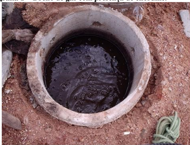
Fotografia 1 - Dreno de gás com presença de chorume.
