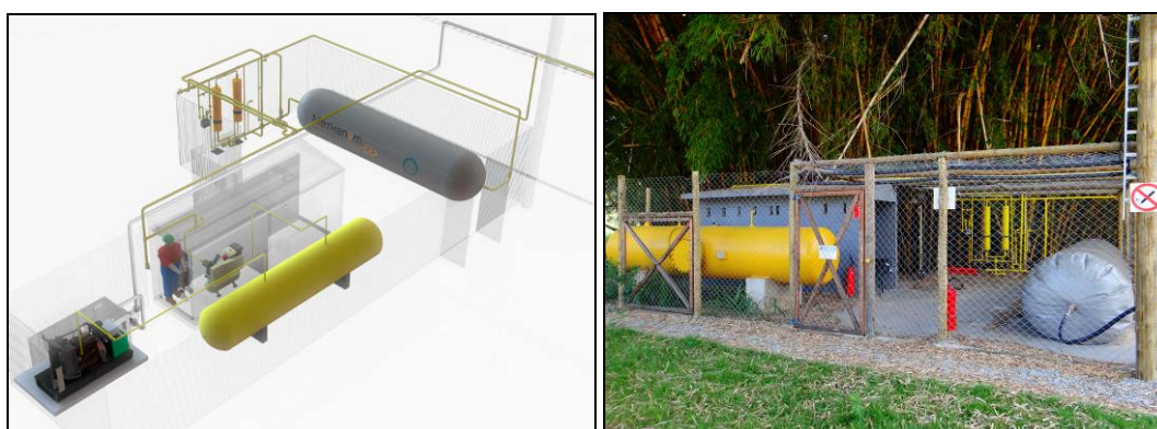
Figura 6: Desenho esquemático e foto da Plataforma de armazenamento, tratamento e aproveitamento energético do biogás
