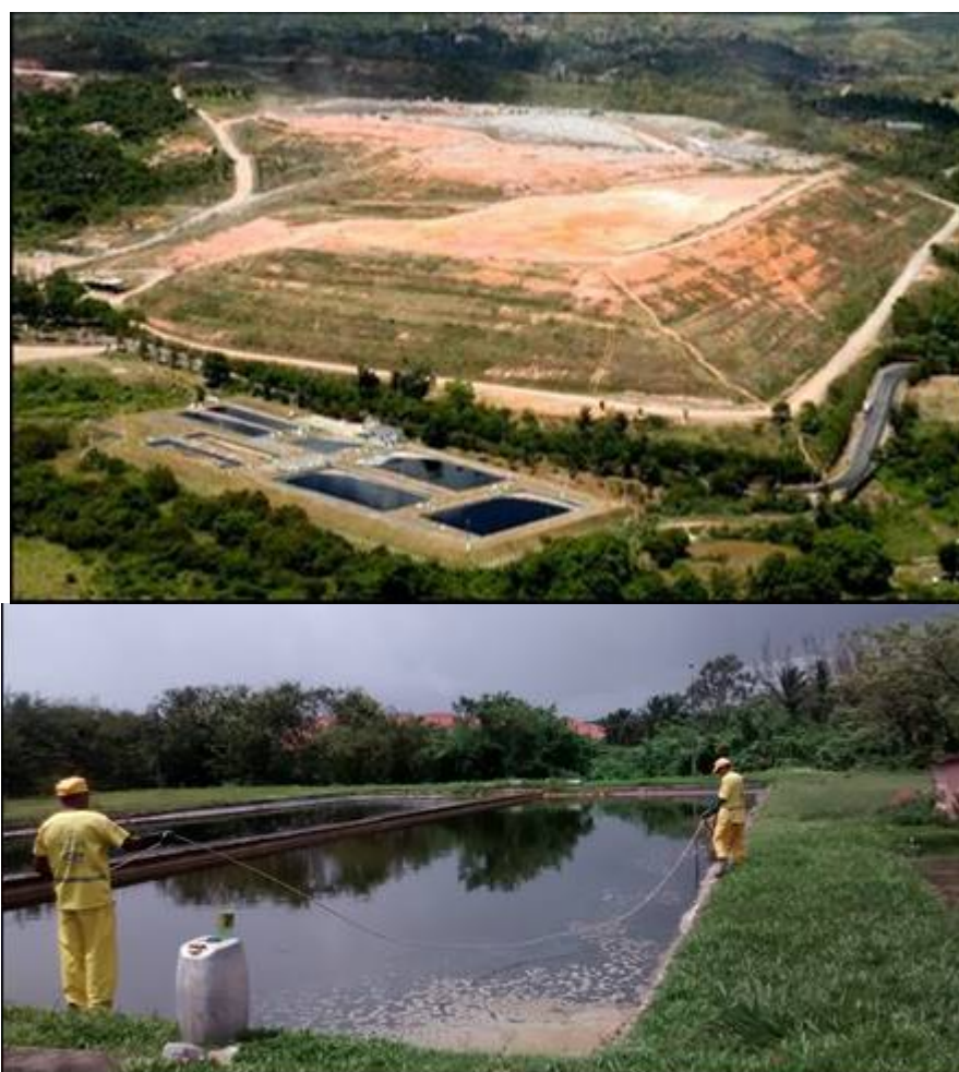
Figura 1. Vista aérea do sistema de lagoas de tratamento de lixiviado do Aterro da Muribeca e da lagoa de decantação durante a realização da coleta do lodo.
