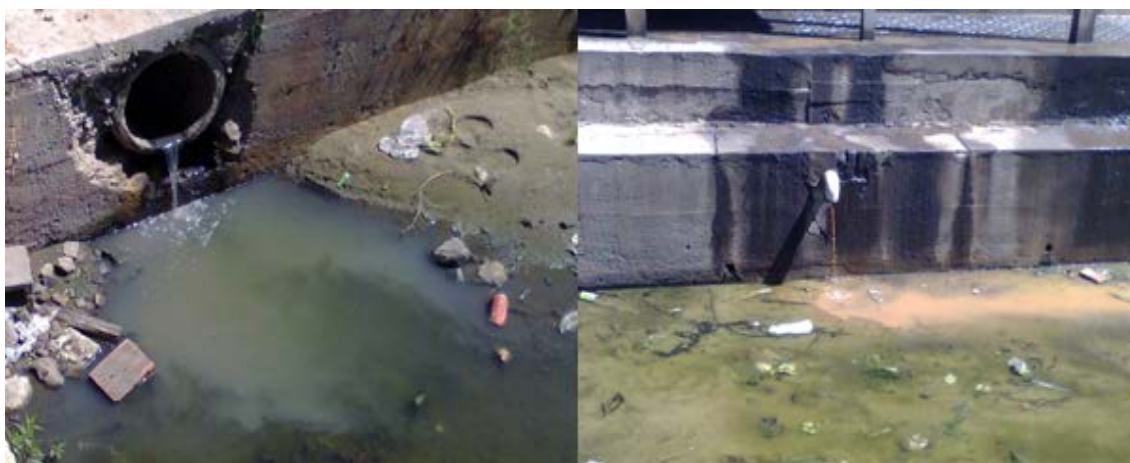
Figuras 2a e 2b – Lançamento de esgotos no canal
