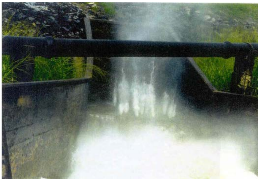
Figura 2 – Vista frontal das explosões devido ao emulsão de ar ao volume de água na tulipa Fonte: SUDECAP/DAM (1998)
