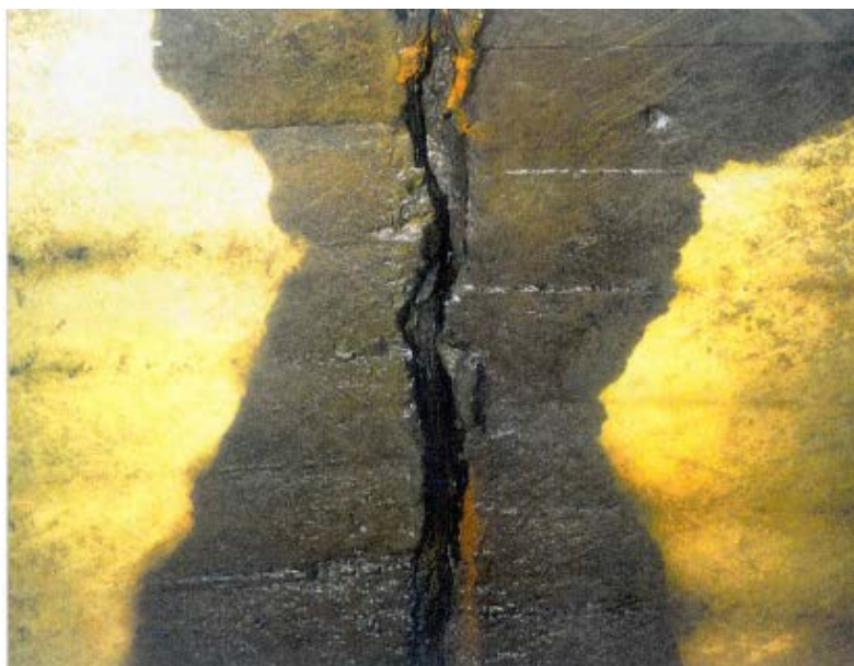
Figura 3 – Juntas abertas no interior da galeria Fonte: SUDECAP/DAM (1998)
