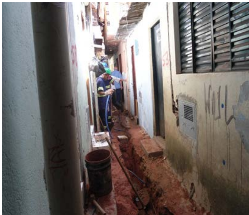
Figura 4: Assentamento de redes de esgoto nas vielas
