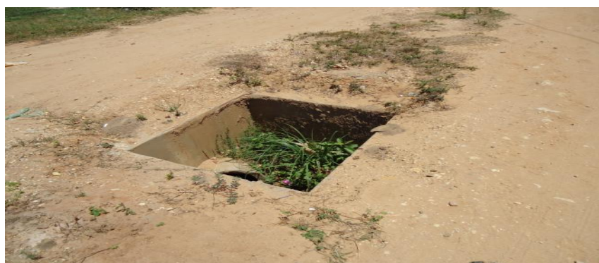
Fotografia 4: Tubulação do esgoto exposta. Divisa da 2ª com a 3ª etapa Fonte: Santos(2014)
