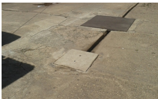
Fig. 08: Caixa separadora de areia e óleo.
