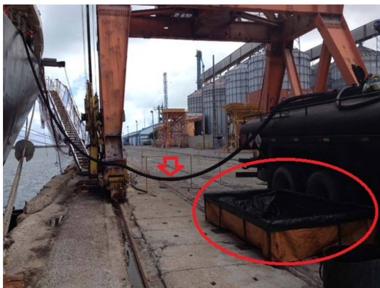
Figura 2: Retirada de água oleosa com o mangote acoplado ao navio e à piscina de contenção conforme o destaque.
