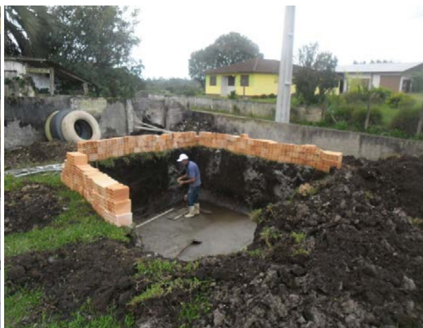
Figura 07 ETEZR para esgoto dos banheiros.
