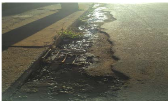
Figura 3: Erosão devido à falta de sarjeta.
