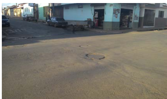
Figura 2: Poço de visita recapeado.
