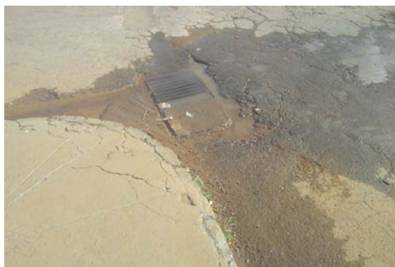
Figura 5: Boca de lobo entupida.
