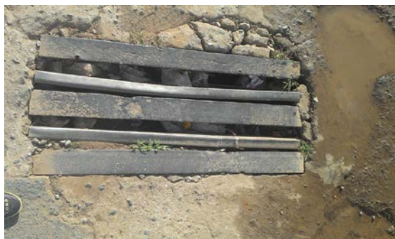
Figura 4: Boca de lobo com sedimentos.
