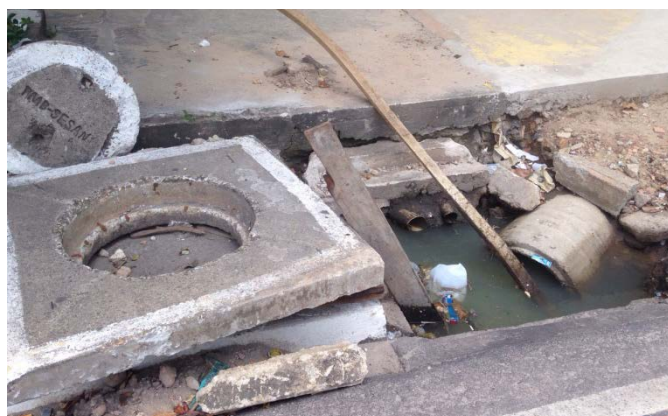
Figura 5: Boca de lobo no trecho da Rua dos Mundurucus sem tampa e entupida. Fonte: Autores.
