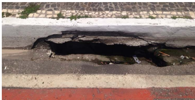
Figura 3: Boca de lobo do tipo simples e sem grelha. Fonte: Autores.
