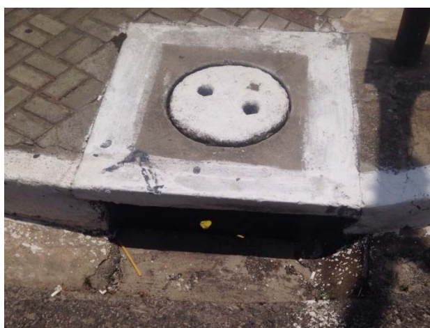
Figura 6: Situação não recomendada para alocar bocas de lobo. Fonte: Autores.
