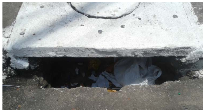
Figura 4: Boca de lobo no trecho da Rua dos Mundurucus obstruída com resíduos sólidos. Fonte: Autores.
