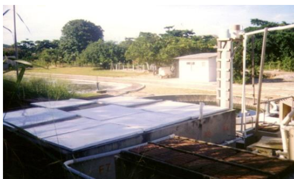
Figura 1: Decanto digestor com filtros anaeróbios
