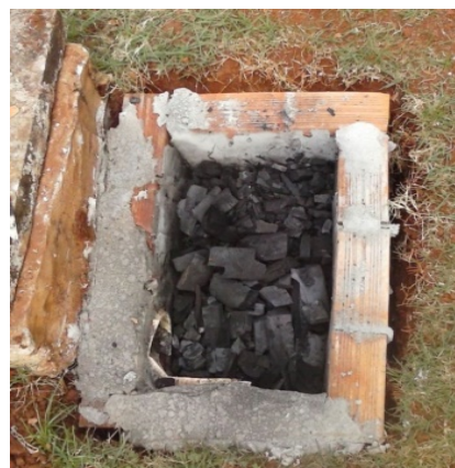
Fotografia 6 - Caixa de carvão vegetal para remover materiais surfactantes
