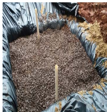
Fotografia 10 - Camada de pedra brita de aproximadamente 45 cm
