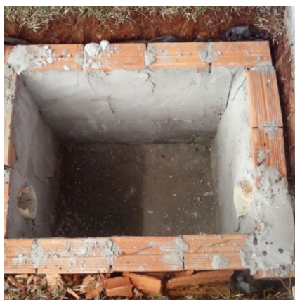
Fotografia 5 - Tanque séptico para as águas provenientes do vaso sanitário
