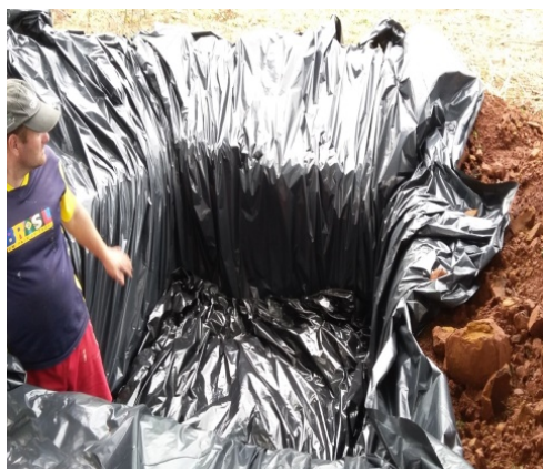
Fotografia 7 - Impermeabilização da ETEZR com lona plástica preta
