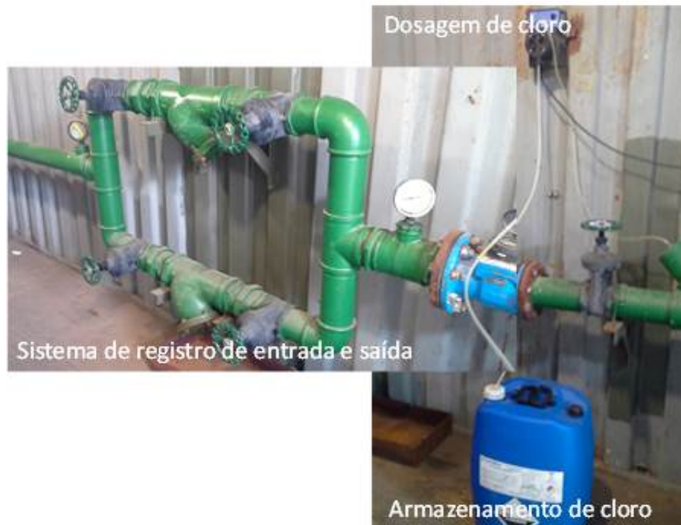
Figura 7: Aparato de cloração do efluente secundário da ETE Alegria.
