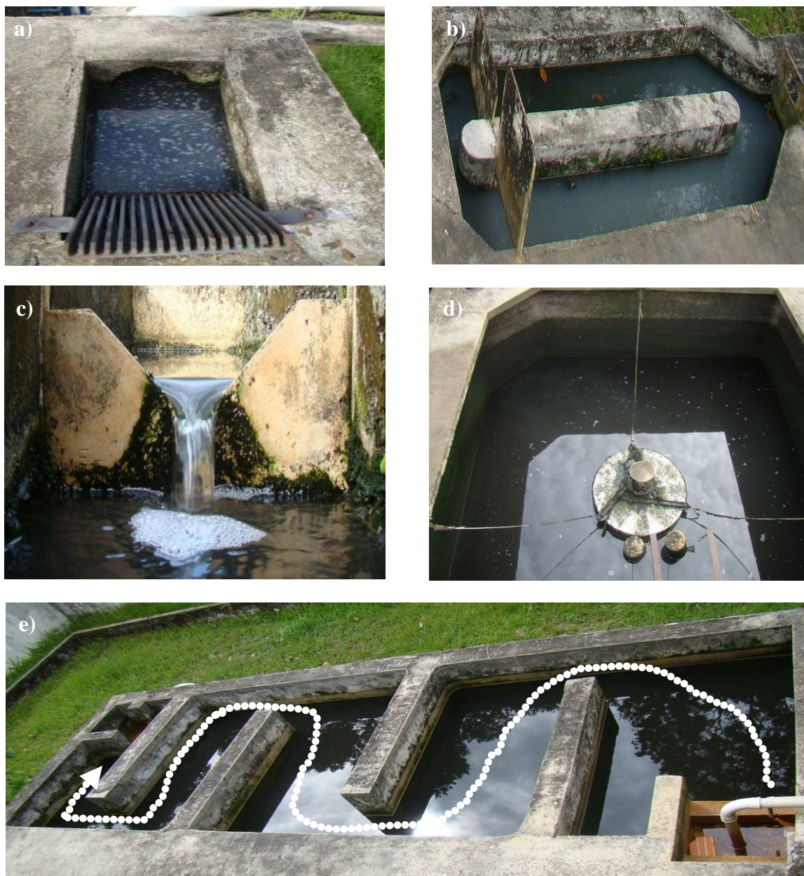
Figura 1: Unidades de tratamento da ETE IEC. a) Gradeamento, b) Desarenador, c) Medidor de vazão, d) Tanque de aeração, e) Tanque de contato (desinfecção)
