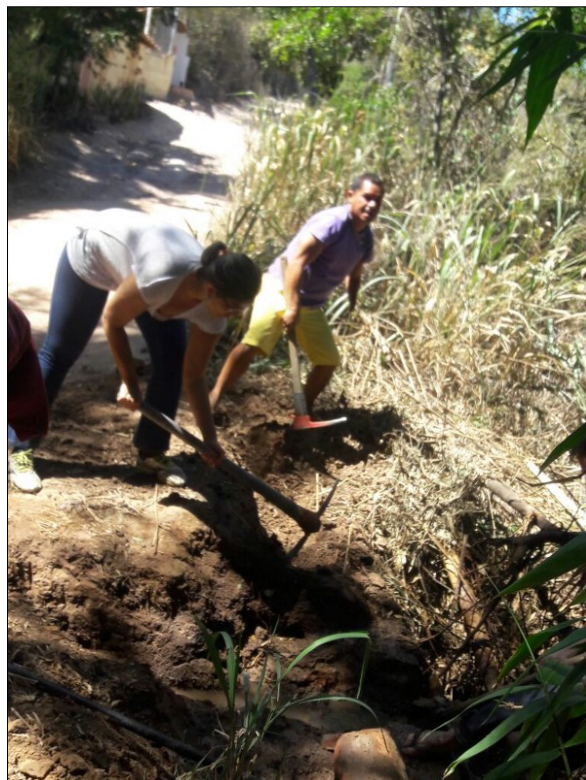
Figura 6: Implantação de descarga em rede de distribuição
