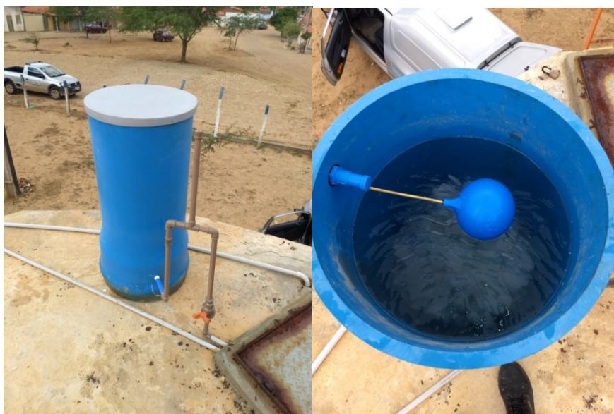
Figura 04 – Torre de lixiviação de tabletes de ácido tricloro
