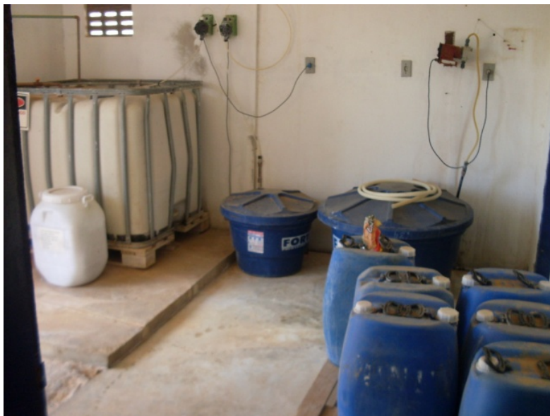
Figura 02 – Sistema de preparo das soluções químicas utilizadas no tratamento de água, Povoado do Quererá / SAA Araci.
