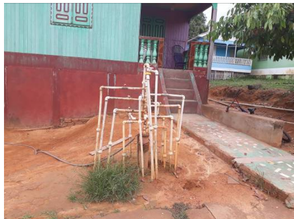
Figuras 2 e 3: Poço sem selo de proteção sanitária e tampa e barrilete de distribuição respectivamente
