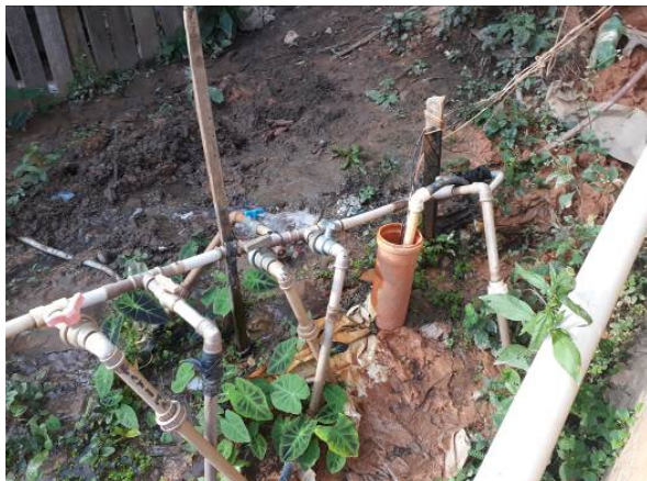
Figuras 2 e 3: Poço sem selo de proteção sanitária e tampa e barrilete de distribuição respectivamente
