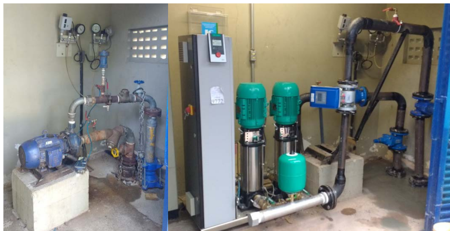
Figura 6 e 7: Sistema de Bombeamento antes e Depois de implantado
