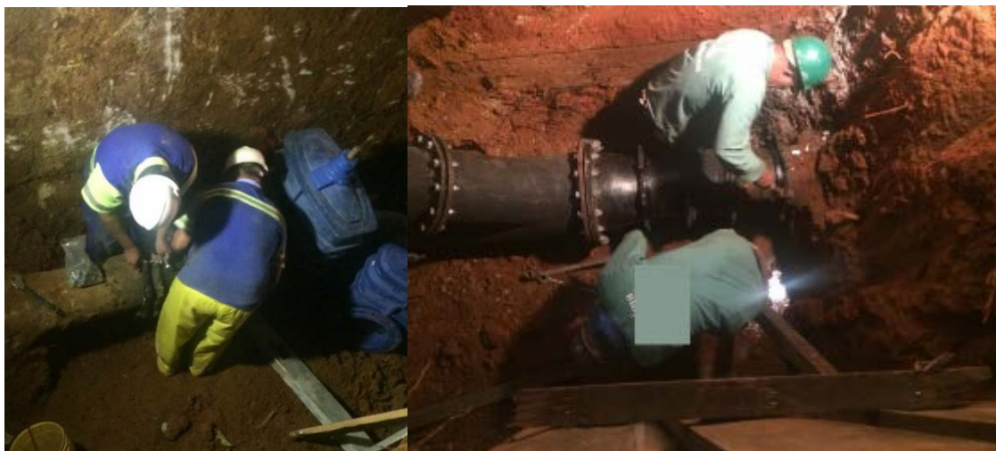
Conexão do Barrilete a tubulação de entrada do reservatório
