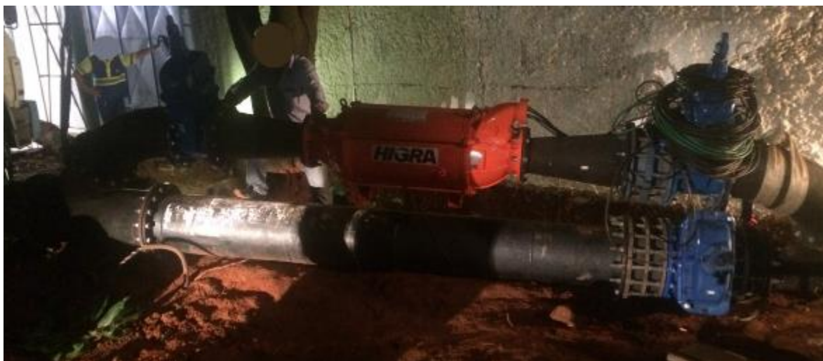
Barrilete de instalação do Turbogenerador
