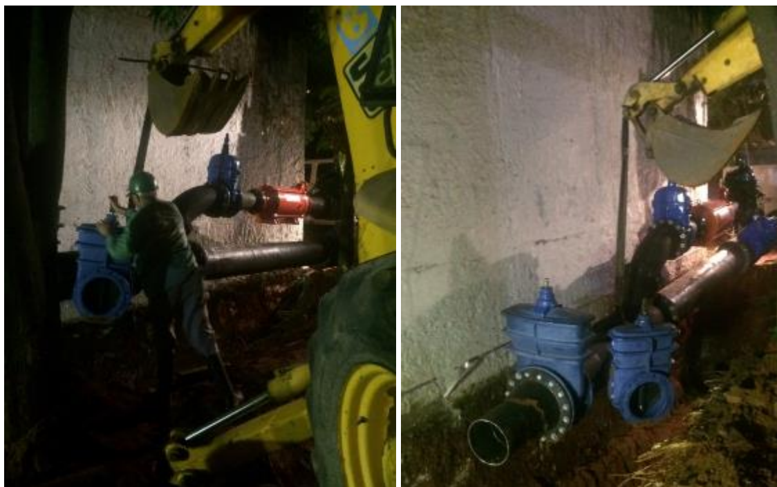
Descida do barrilete para instalação
