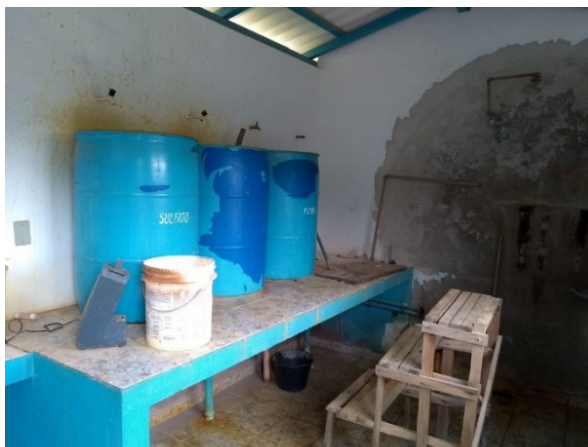
Figura 3: Processo avançado de Infiltração no interior da casa de química da ETA de Camargo.
