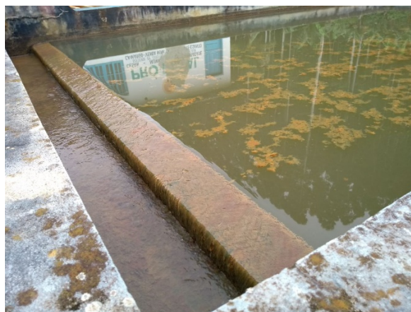
Figura 4: Presença de flocos na superfície do decantador da ETA de Camargo.
