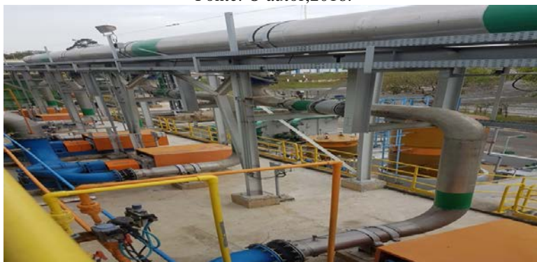
Fotografia 4- bombas de lóbulos dentro das caixas laranjas, linha de hipoclorito de sódio em amarelo, linha de ácido cítrico em laranja, tanques de hipoclorito de sódio e ácido cítrico, tubulação de aço inferior de água permeada e superior de água decantada/bruta.
