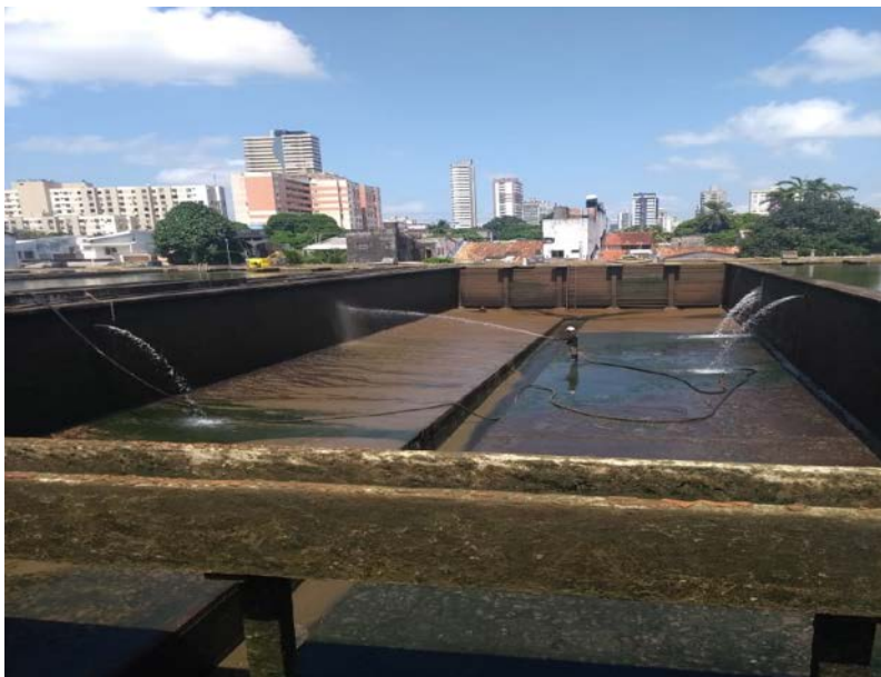
Figura 2: Processo de lavagem manual dos tanques de decantação da ETA SÃO BRÁS
