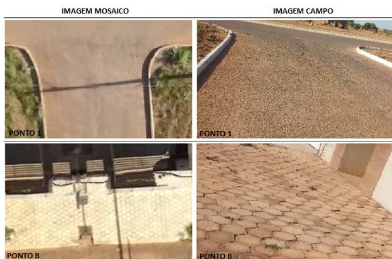
Figura 2. Ponto 1 (Revestimento asfáltico em travessia) e ponto B (Intertravado sextavado).
