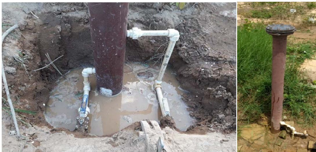
Figura 03 – Dosador hidráulico idealizado e instalado no SIAA Zoador no dia da montagem e após 12 meses de uso.
