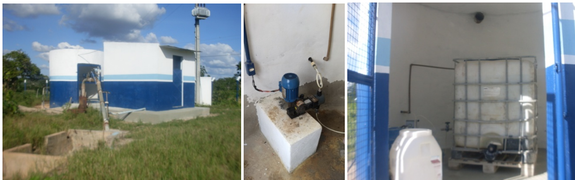
Figura 01 – Sistema de Tratamento SIAA de Zoador (Sistema de preparo e dosagem da solução clorada)
