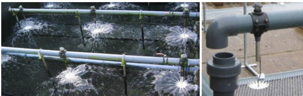
Figura 8: Sistema de distribuição estático ou fixo e detalhe da tubulação e do aspersor
