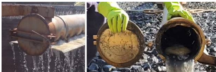
Figura 10: Acesso para limpeza na extremidade do braço de distribuição
