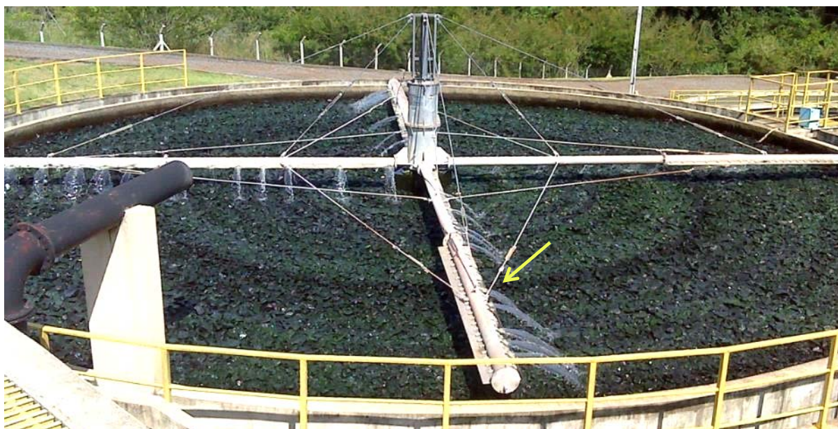
Figura 11: Falhas no crescimento do biofilme ocasionadas por distribuição não uniforme (sinalizadas com a flecha amarela na figura)
