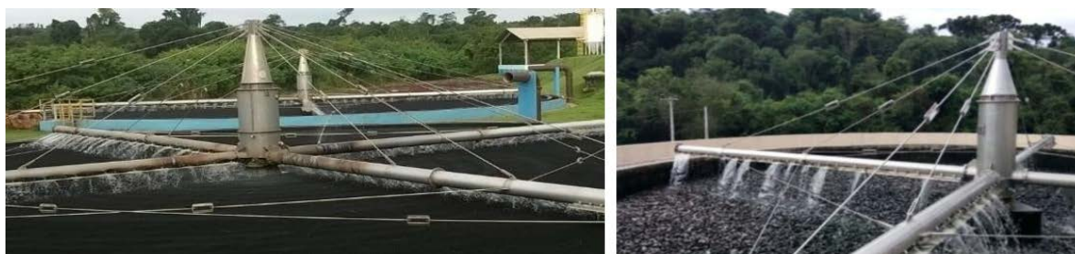
Figura 1: Sistema em aço inox AISI 304 com corrosão e sistema em aço inox 316 em bom estado
