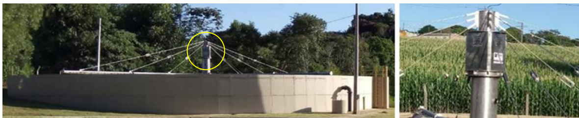
Figura 4: Filtro percolador com motor instalado no sistema de distribuição do afluente
