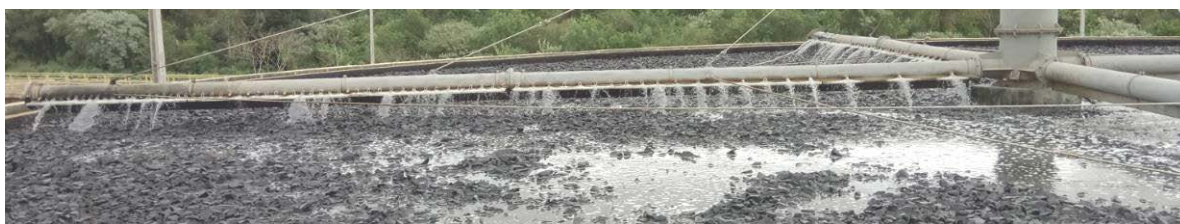
Figura 9: Distribuição não uniforme do afluente e taxa de aplicação hidráulica não uniforme
