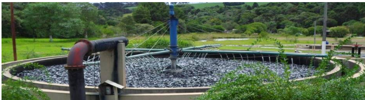
Figura 2: Sistema de distribuição com braços em CPVC
