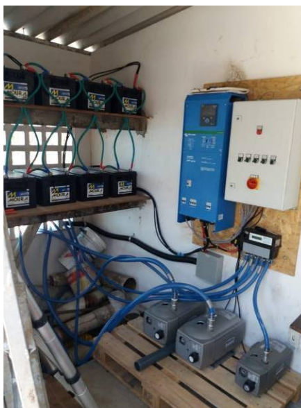
Figura 9: Conexão das bombas na unidade de controle, baterias do sistema e inversor elétrico em azul da ETESA
