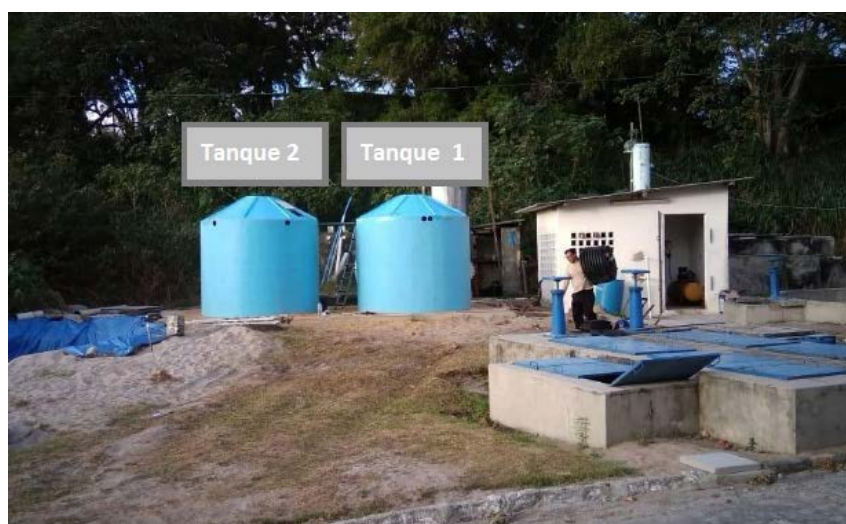
Figura 4: Disposição dos tanques na área de instalação da ETESA de pequeno porte
