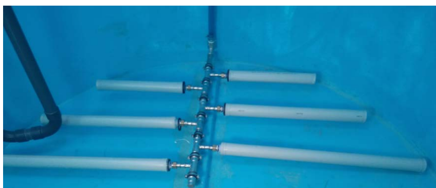
Figura 5: Detalhe do sistema de aeração utilizado no fundo dos tanques da ETESA
