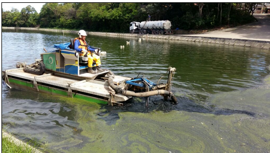
Figura 3 - Operação de dragagem de lodo na ETE.
