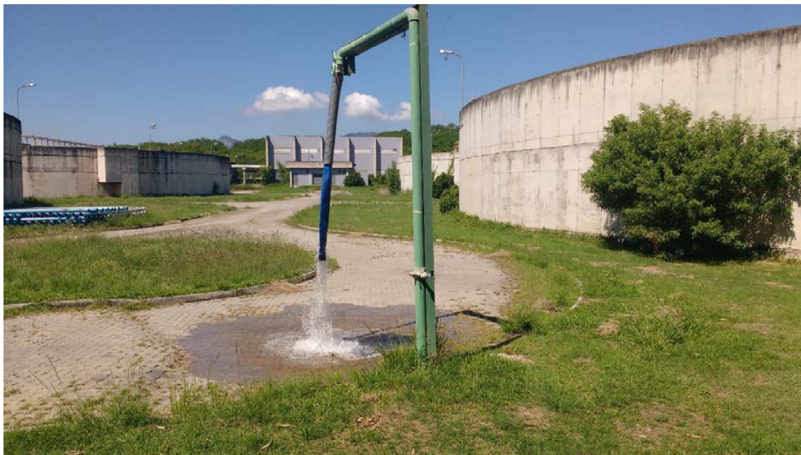
Figura 1: Sistema de abastecimento dos caminhões pipa com água de reuso na ETE Alegria
