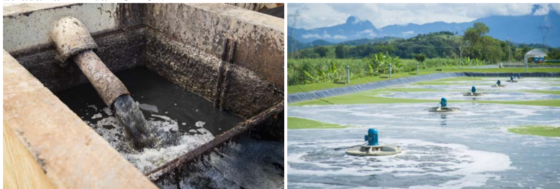
Figura 1 – Caixa de chegada e gradeamento do afluyente bruto. Figura 2 – 1ª Lagoa de estabilização aerada na ETE da ACTION
