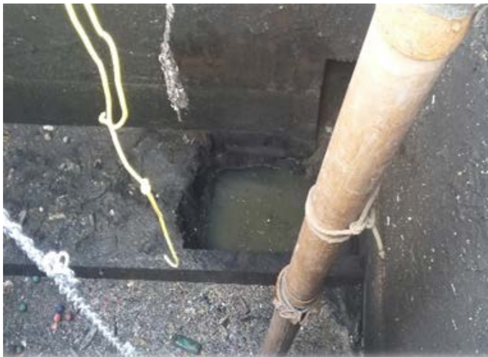
Figura 2 - Sobrenadantes acumulados no poço de sucção
