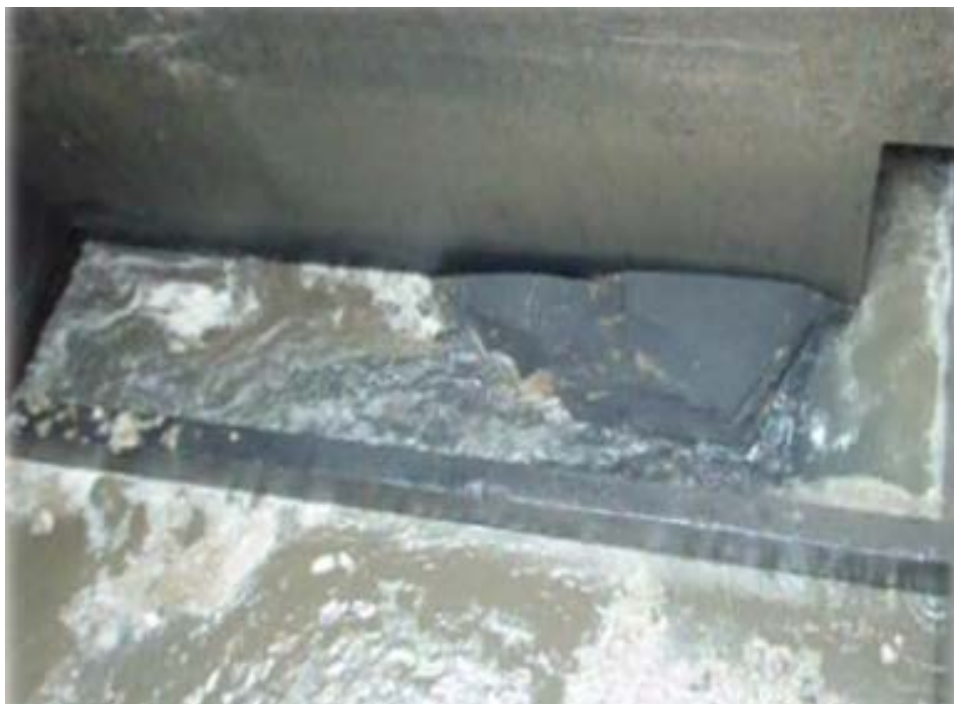
Figura 1 - Areia acumulada no poço de sucção
