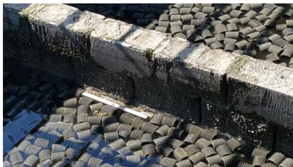
Figura 2 - Mídia antiga da ETE Gêneses - foto tirada com aeração desligada
